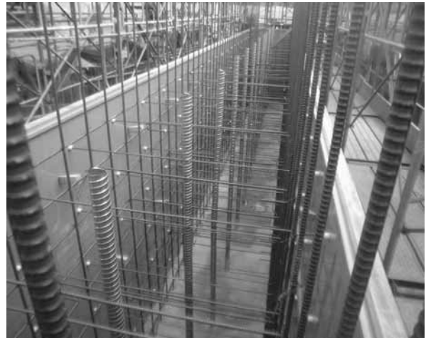
写真-1 シース管取付状況
