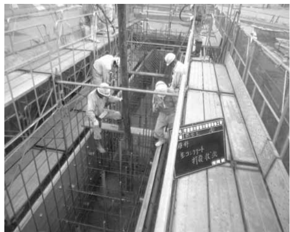
写真-2 コンクリート打込み状況
