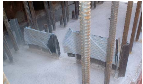
写真-1 ひび割れ誘発目地材設置状況
